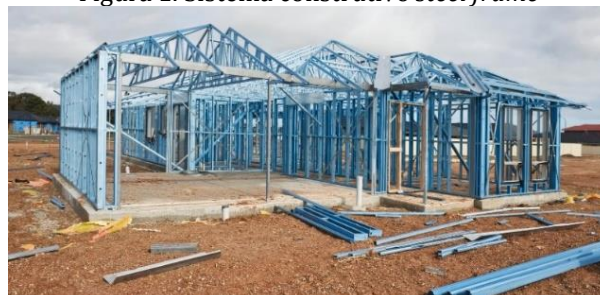
Figura 1. Sistema construtivo steel frame
