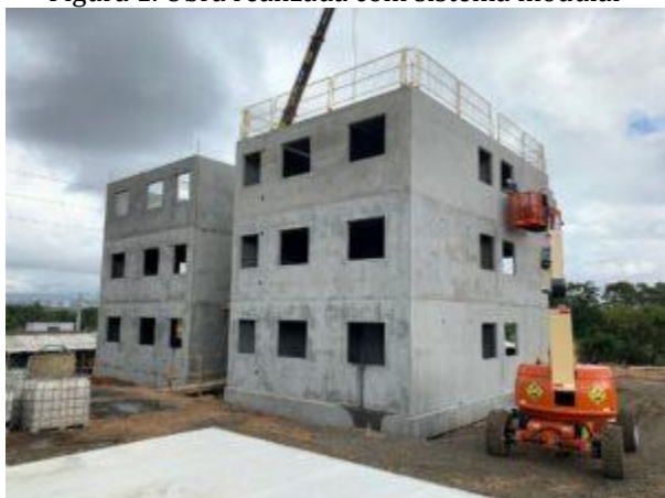
Figura 1. Obra realizada com sistema modular
