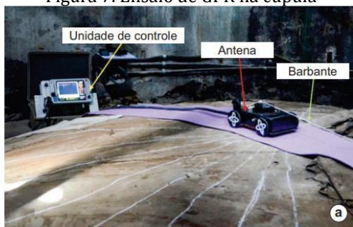
Figura 7. Ensaio de GPR na cúpula
